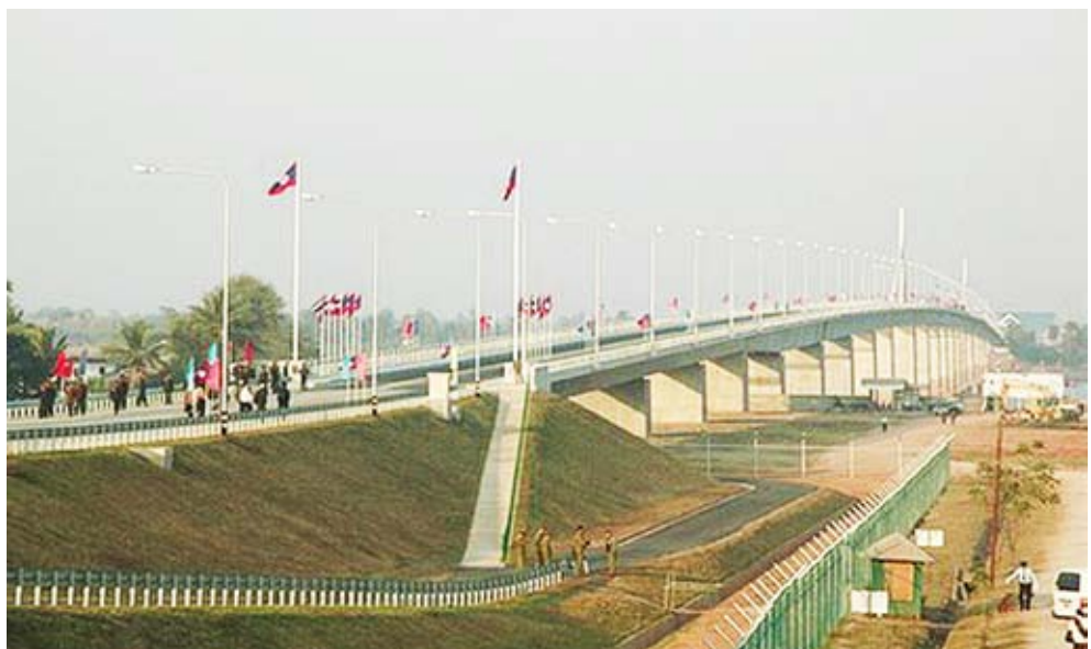
ຂົວມິດຕະພາບ ລາວ - ໄທ ແຫ່ງທີ່ສອງ ທີ່ແຂວງສະຫວັນນະເຂດ
